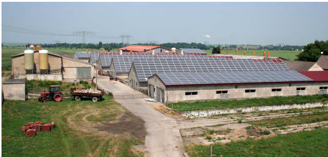
Foto: meridian Neue Energien GmbH
